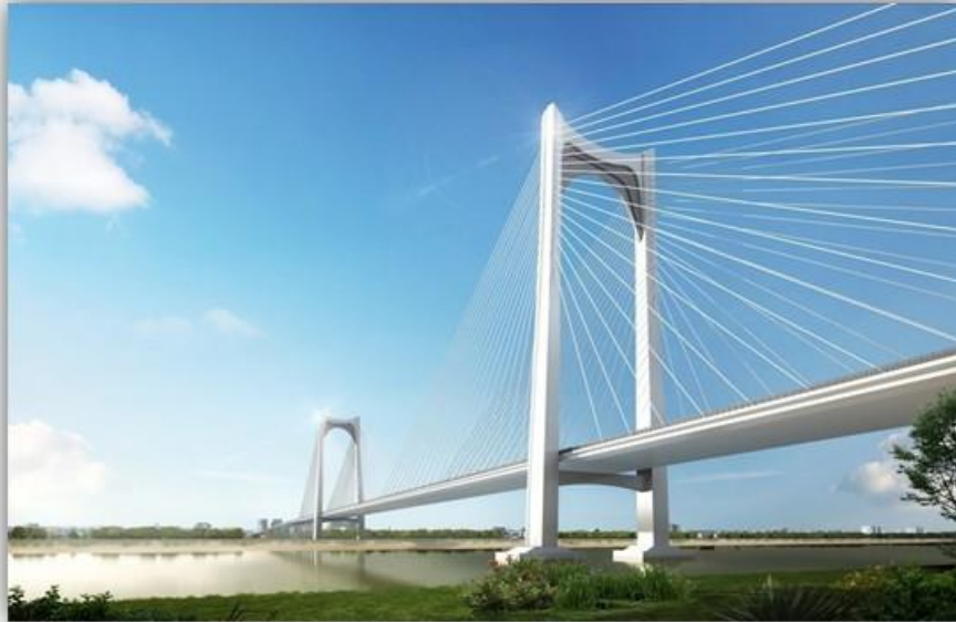
沾臨公路黃河特大橋 442m, 雙邊箱-UHPC預製板組合梁
